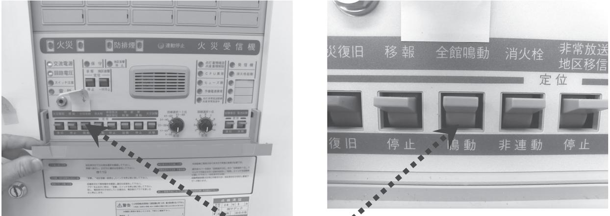
職員室背面の操作盤の蓋を開けると右図のスイッチがある。
